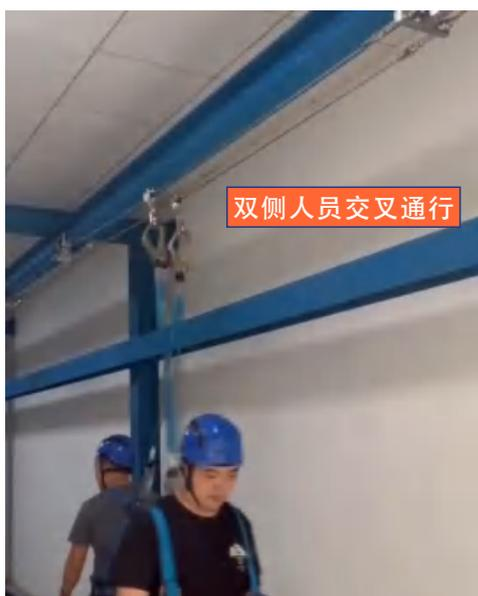
当生命线两侧的人员相遇时，无需拆开任何一方的连接，即可迅速交叉通过，这最大降低了发生坠落的风险。
